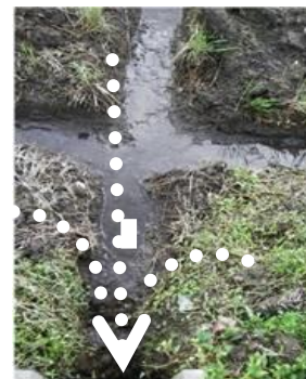
排水口を深く掘り下げ、排水口へつなげる。
